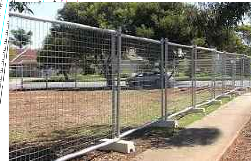
Пример временного ограждения при въезде на стр. площадку
