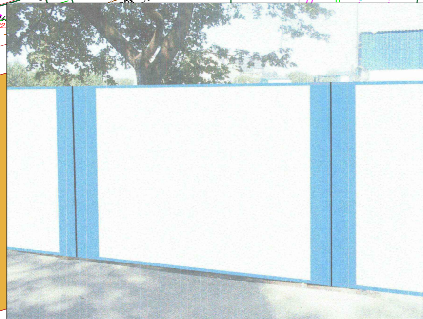
Пример временного ограждения
